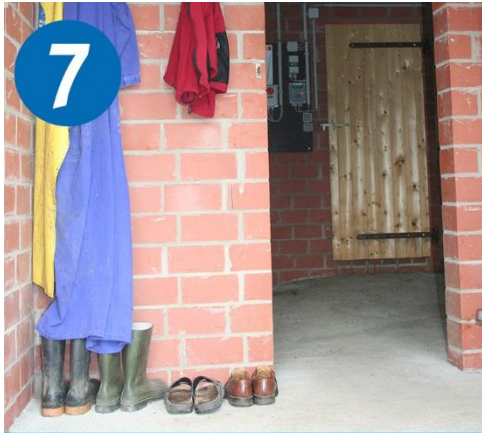
Falta esclusa higiénica
